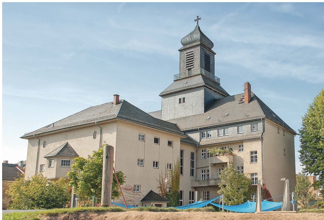
Kompakt gebaut: die von Friedrich Pützer (1871–1922) entworfene Lutherkirche in Offenbach.
